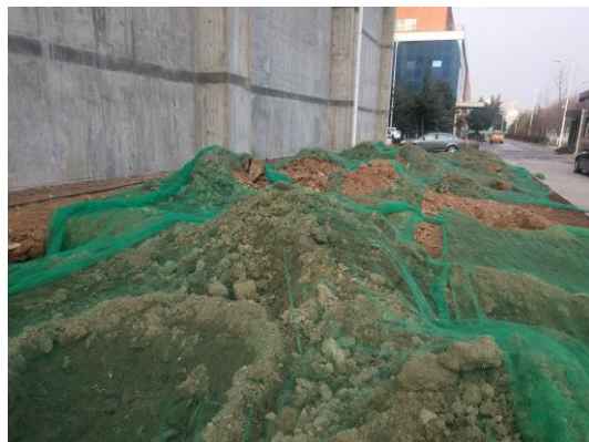
绿化区抑尘网苫盖
