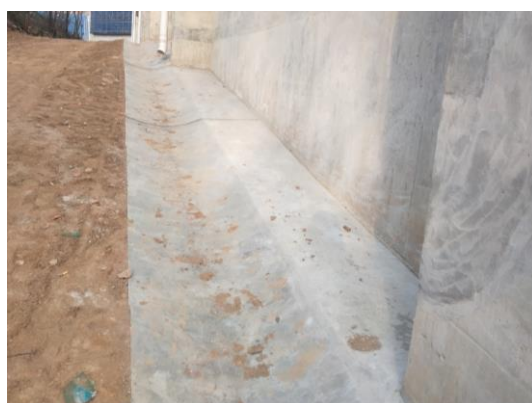
厂房周围排水沟
