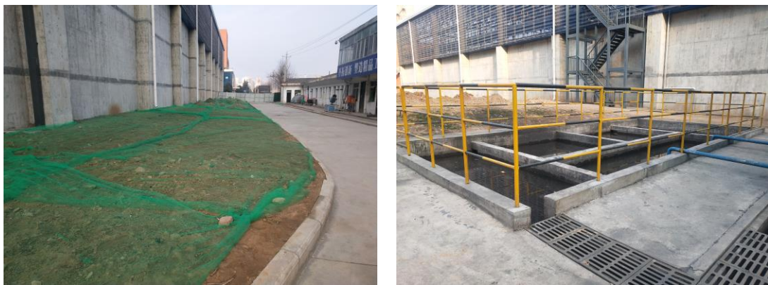
图 1-1 项目建设现状
